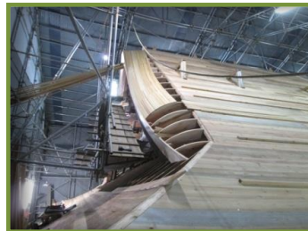
構型に合わせて、幅の狭い小割棧を打ちつけて、美しい曲線を作ります。
